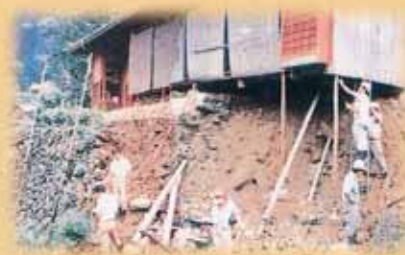
写真2 がけ崩れて土台を失った家屋(S57 多賀町入谷)
