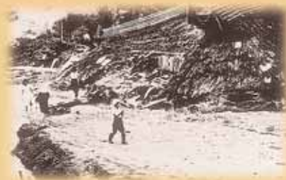
写真1 土石流で倒壊した家屋 (S28 甲賀市信楽町多羅尾) 死者行方不明者44名
