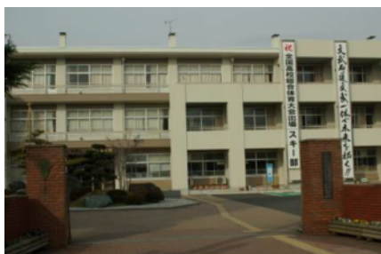
校舎前景 全棟耐震工事了
