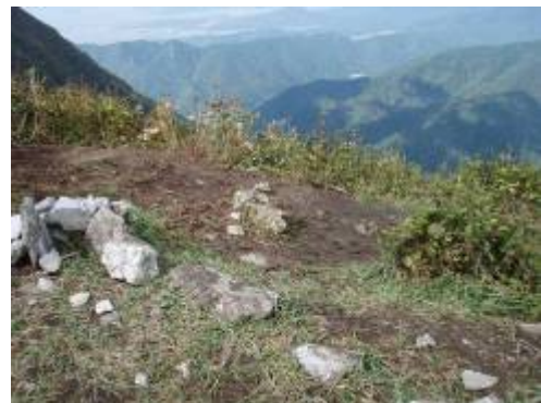
道路下部斜面が刈り取られている
