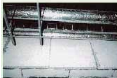
石棉含有ケイ酸カルシウム系（2造）（5造の耐火被覆）
