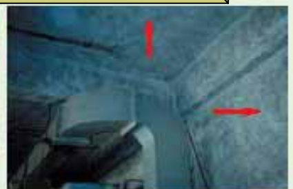
吹付アスベスト・石棉含有吹付ロックウール（築造時）
