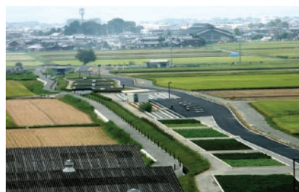
③市街地排水浄化施設の例(山寺川)
