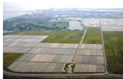
①循環かんがい施設の例(木浜地区)
